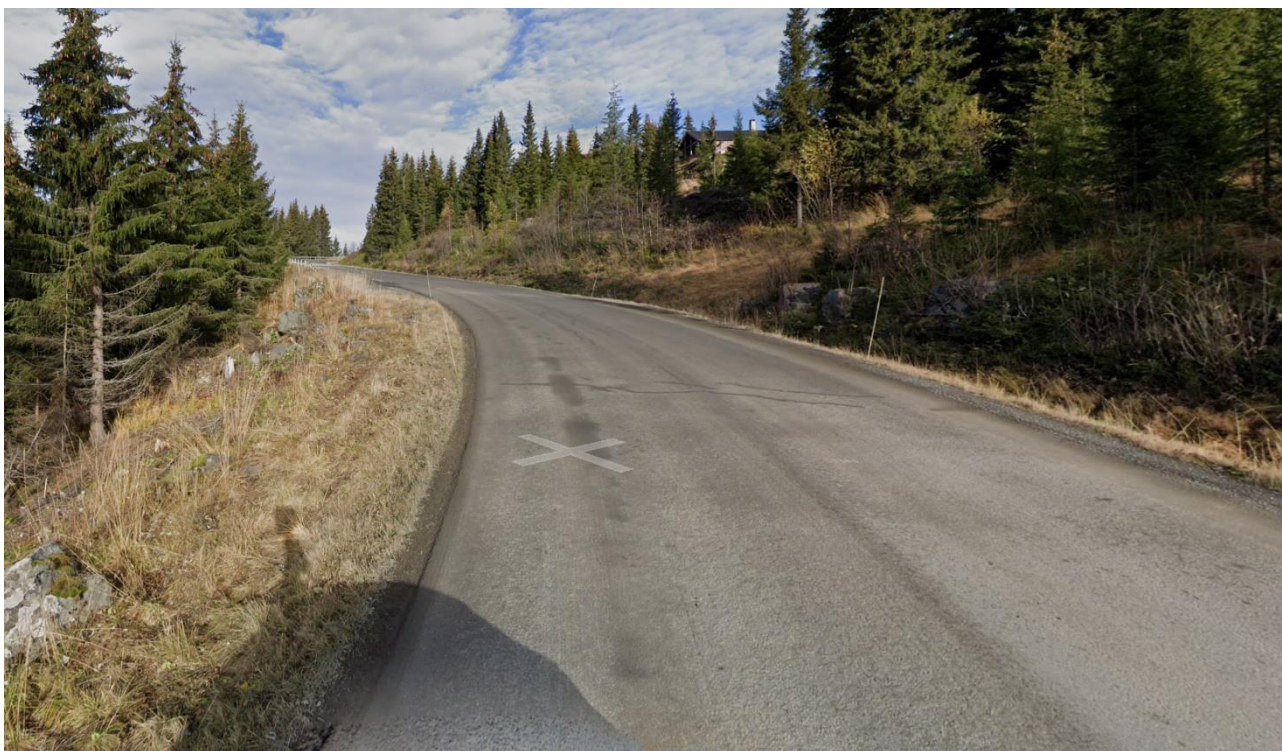
Figur 5-12 viser siktforholdene ved avkjøringen til planområdet sett mot nord. (Kilde: Google Street-view)
