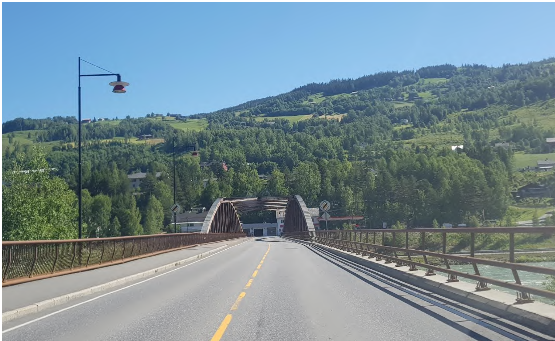
Tverrsnitt av 2012-brua, Tretten. Fra vest mot øst (foto: Steinar Svensbakken).
