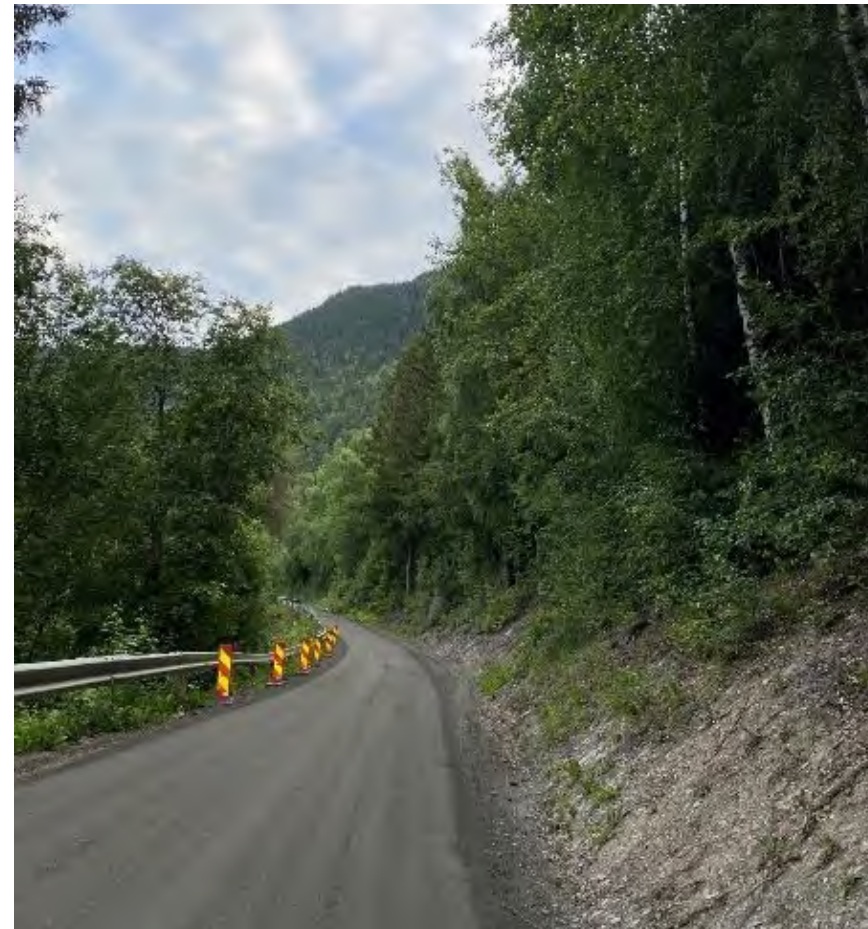
Vestsidevegen, fv. 2532, på strekningen mellom Tretten og Fåvang. Foto: Ingrid Rindal Øvsteng
