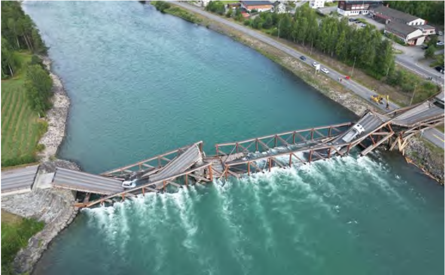
Tretten bru 2012, 15. august 2022. Foto: Erik Rebne Larsstuen/Statens vegvesen.
