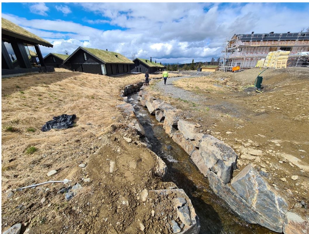
Figur 4-2: Bekkeløp i Nørdre Slåbekken, oppstrøms FLS3
