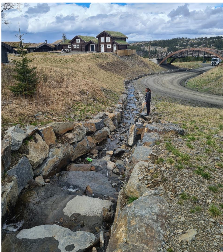
Figur 4-6: Bekkeløp i midtre/nedre deler av Søre Slåbekken.
