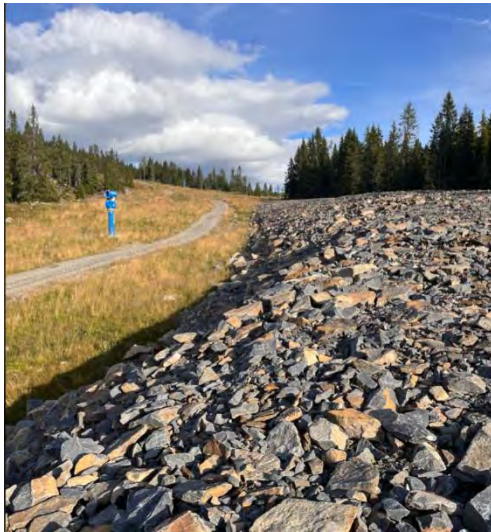
Figur 3: Eksempel på dårlig estetikk og landskapshensyn: Etablering av skitråse med grov stein. Vanskelig framkommelig sommerstid og skjemmende i landskapet.
