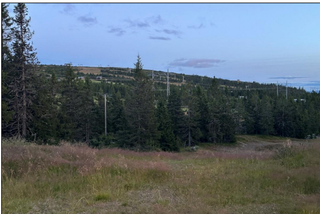
Figur 15: Bildet viser hvordan teknisk infrastruktur, blant annet kraftlinjer, master og heiser, er synlig i landskapet rundt Nysætra. Bildet er tatt fra avstigningen på Mosæterheisen
