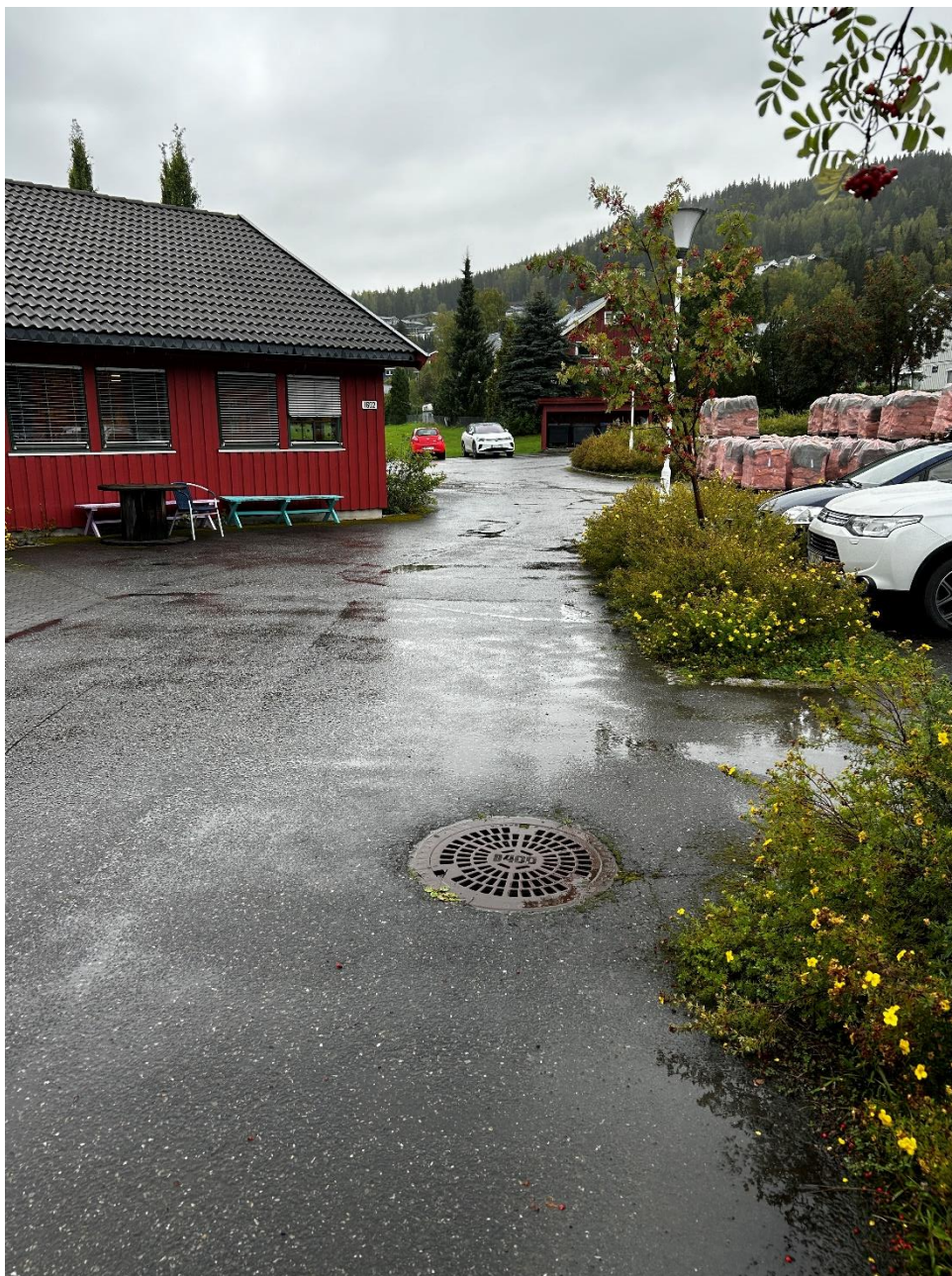
Figur 11: Sandfangskum på parkeringsplassen øst for eksisterende bebyggelse.
