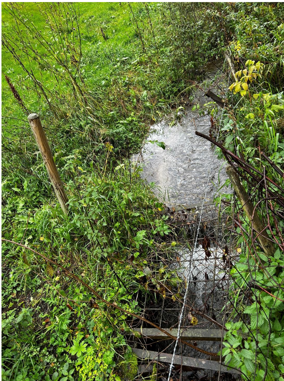
Figur 8: Bekkeinntak oppstrøms Toppavegen. Innløpsrist med overløpsrist.
