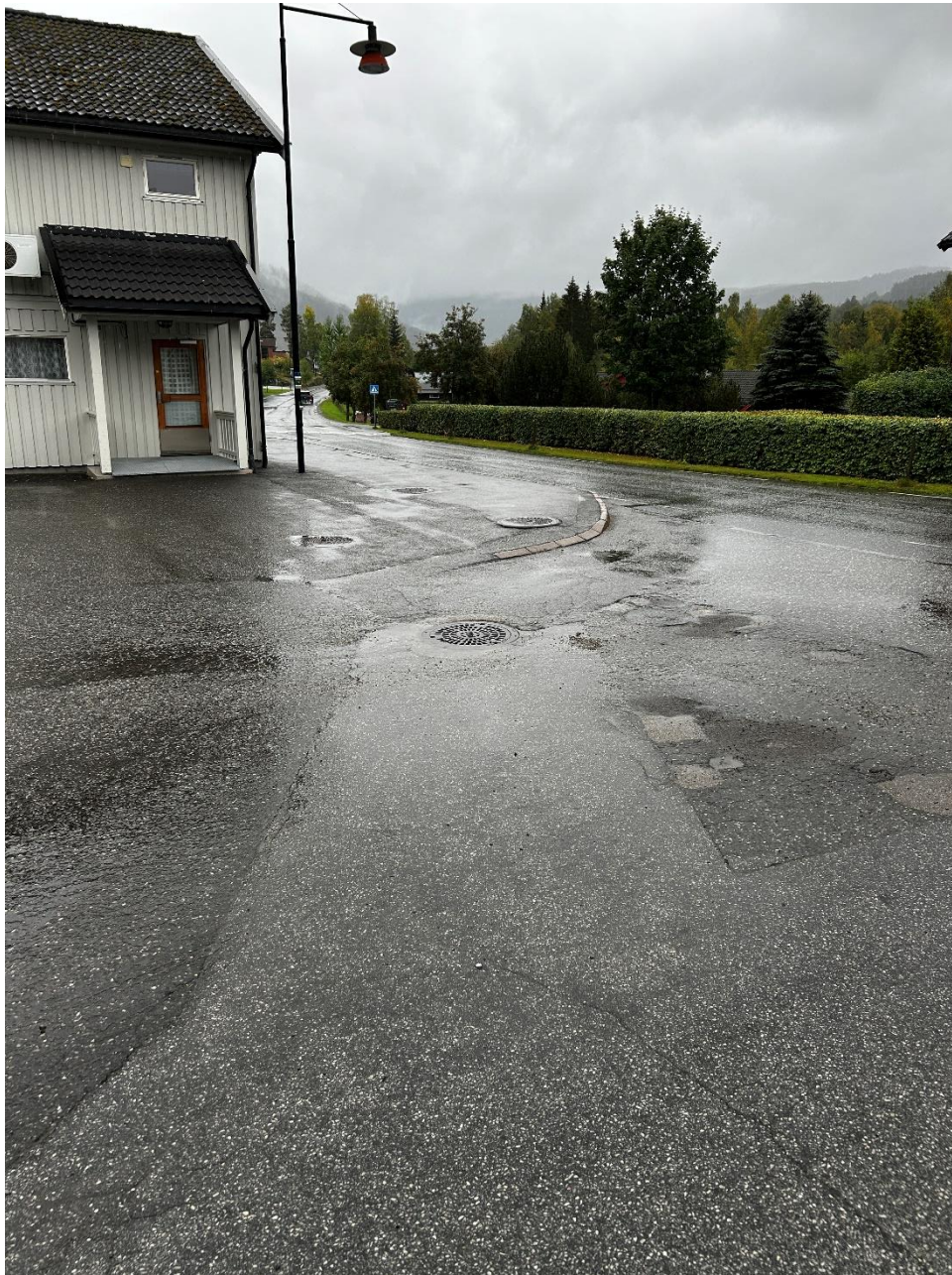
Figur 10: Sandfangkum oppstrøms Kongsvegen, ved innkjøringen til Kiwi.
