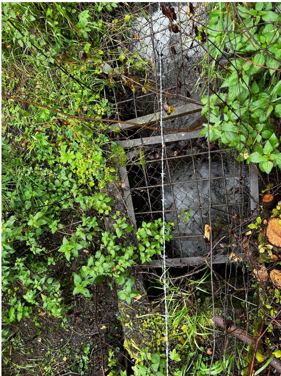
Figur 9: Bekkeinntak oppstrøms Toppavegen. Innløpsrist med overløpsrist.
