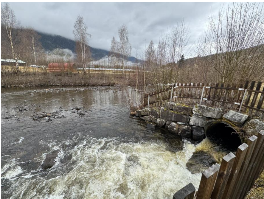
Figur 4-16 viser utløpskanalen fra Moksa kraftverk langs Moksa.
