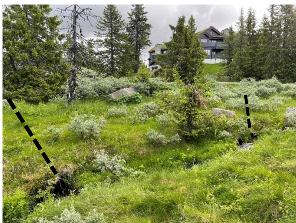
FIGUR 19 BILDE OMRÅDE D: STIKKRENNER, BEGGE ER 400 MM, TROLIG FOR SKILØYPE
