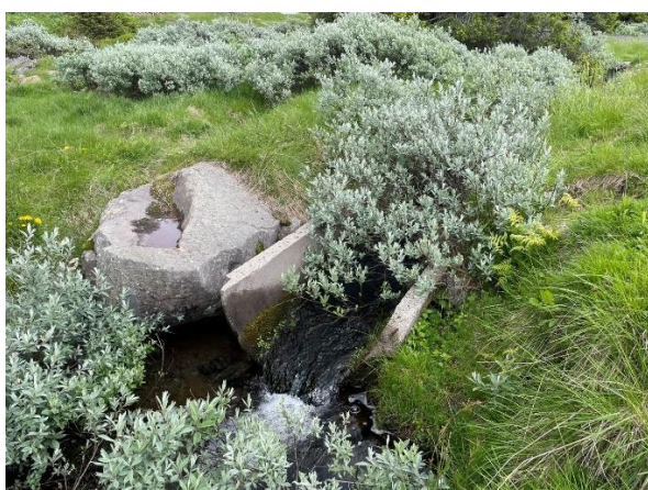
FIGUR 23 BILDE OMRÅDE H: ET BETONGRØR MED DIAMETER 800 MM ER DELT I TO OG LAGT I BEKKEBUNN FRA STIKKRENNE OG CA 20 M NEDOVER, TROLIG SOM ET TILTAK MOT EROSIJON.
