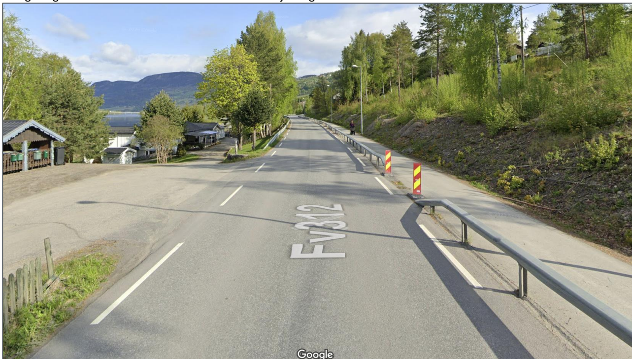
Figur 7: Innkjøring til planområdet sett mot nord. Bilde hentet fra Google streetview.
