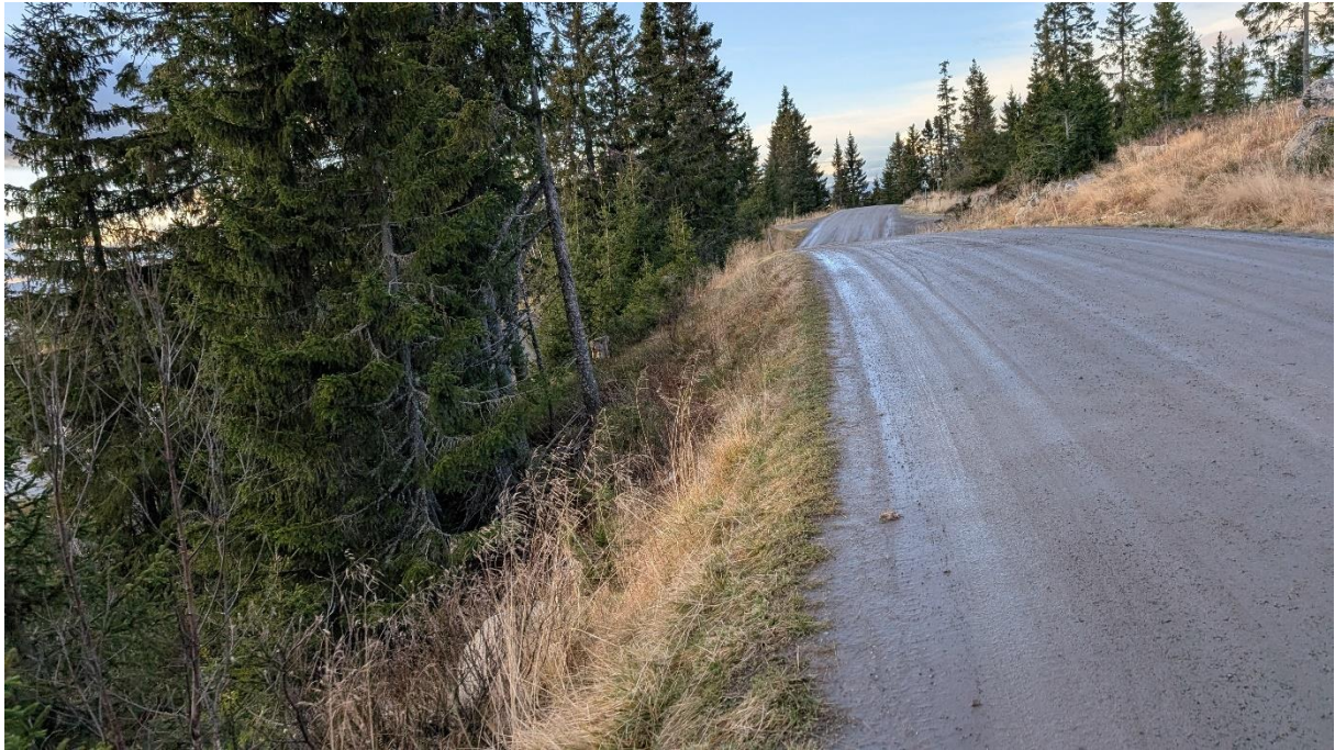
Figur 7: Lunnstadmyrvegen ligger lett i terrenget med krappe overganger særlig i vertikalplanet (vegens lengdeprofil)
