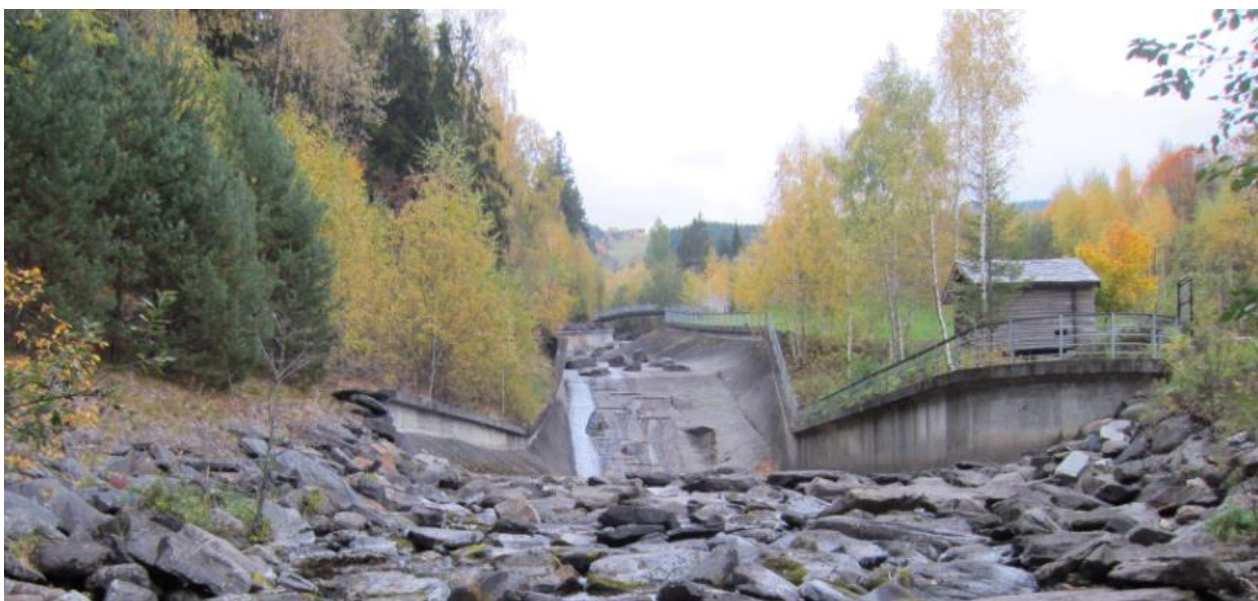
Sikringsanlegg i Moksafoto Øyer kommune
