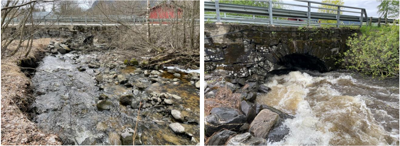
Figur 2. Til venstre: Forhold oppstrøms brua i Gamlevegen med lav vannføring under befaring 27.04.2023. Til høyre: Forhold oppstrøms brua i Gamlevegen under større vannføring 23.05.2023.
