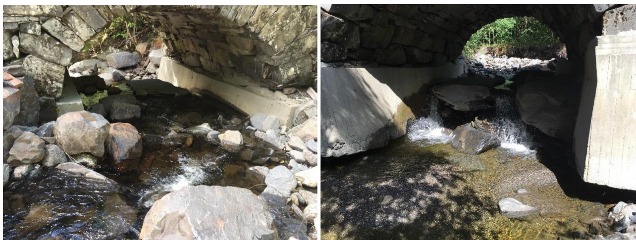
Figur 1. Bilde av bru i Gamlevegen, (til venstre) sett fra oppstrøms, (til høyre) sett fra nedstrøms. Norconsult 05-08-2018.
