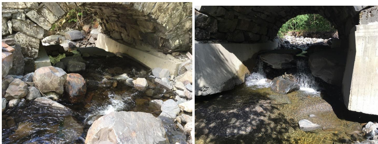
Figur 3: Forhold under dagens bru med lav vannføring. Til venstre: Utsikt fra oppstrøms brua. Til høyre: Utsikt fra nedstrøms brua. Foto: Norconsult, 2018.08.05.
