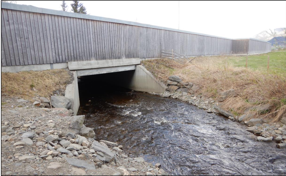
Figur 21: Bilde av innløpet av kulverten under E6.
