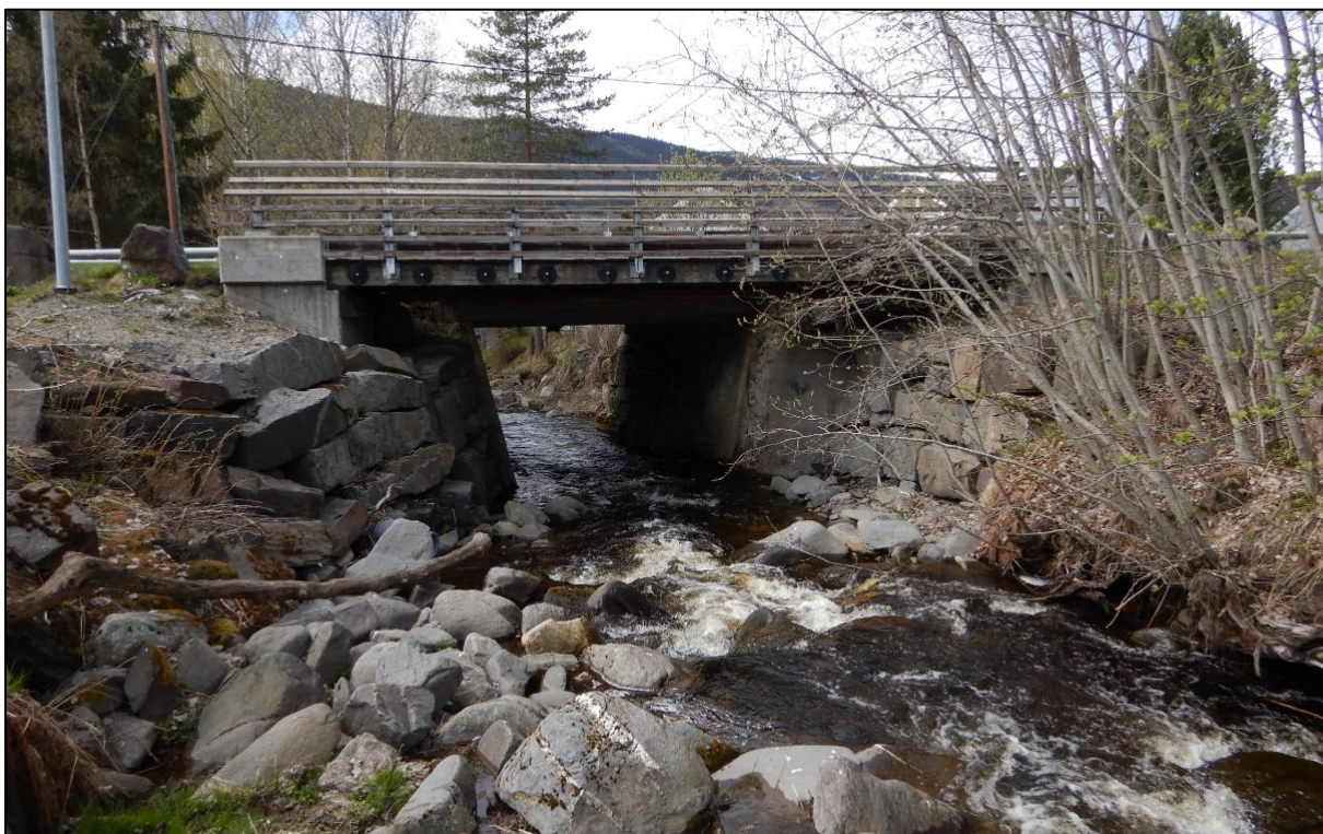
Figur 19: Bru Kongsvegen sett fra oppstrøms side.
