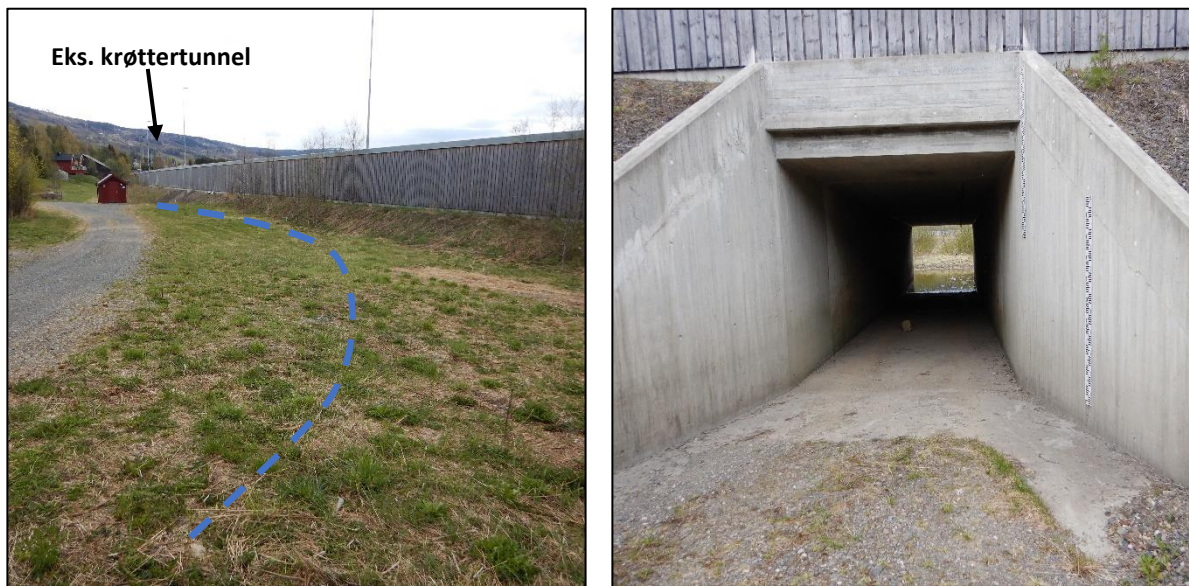
Figur 16: Bilder av trase til foreslått flomvei langs E6 og eksisterende krøttertunnel.
