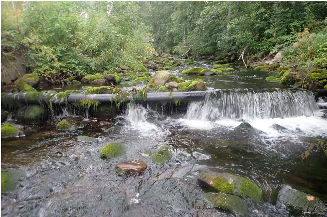
Figur 6. Vannrør som krysser Søre Brynsåas nedre del (mellom E6 og Kongsvegen) utgjør trolig et vandringshindrende element på de lavere vannføringene. Det er uvisst om røret kan være vandringshindrende også på noe høyere vannføringer.
